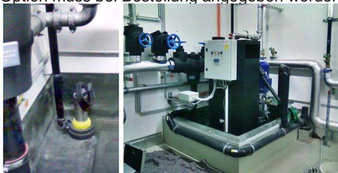
Verkabelung und Montage erfolgen bauseits. Um den dauerhaften Betrieb der Druckerhöhung zu gewährleisten muss diese auf einen bauseitigen Sockel mit den Abmessungen 1 × 1 × 0,25 m innerhalb der Abmauerung gestellt werden. Für die im Standardbetrieb (Prüfläufe lt. TRVB 128) in geringen Mengen anfallenden Abwässer ist der Überlauf DN 100 des Vorlagebehälters an einen Abfluss außerhalb der Ummauerung zu leiten.
