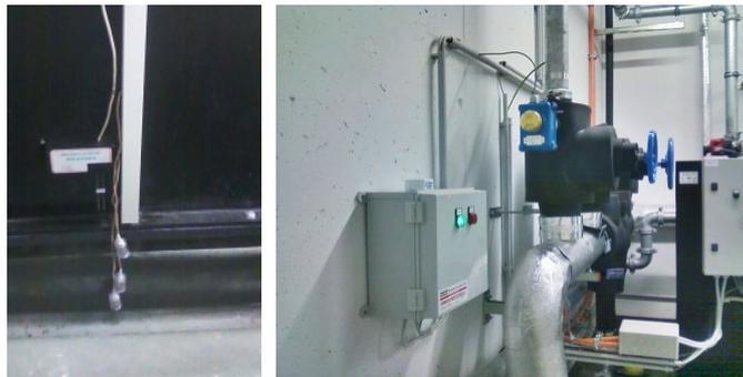
Die Zulaufabschottung öffnet sich automatisch wieder sobald die Störmeldung nicht mehr vorliegt. Verkabelung und Montage erfolgen bauseits.
